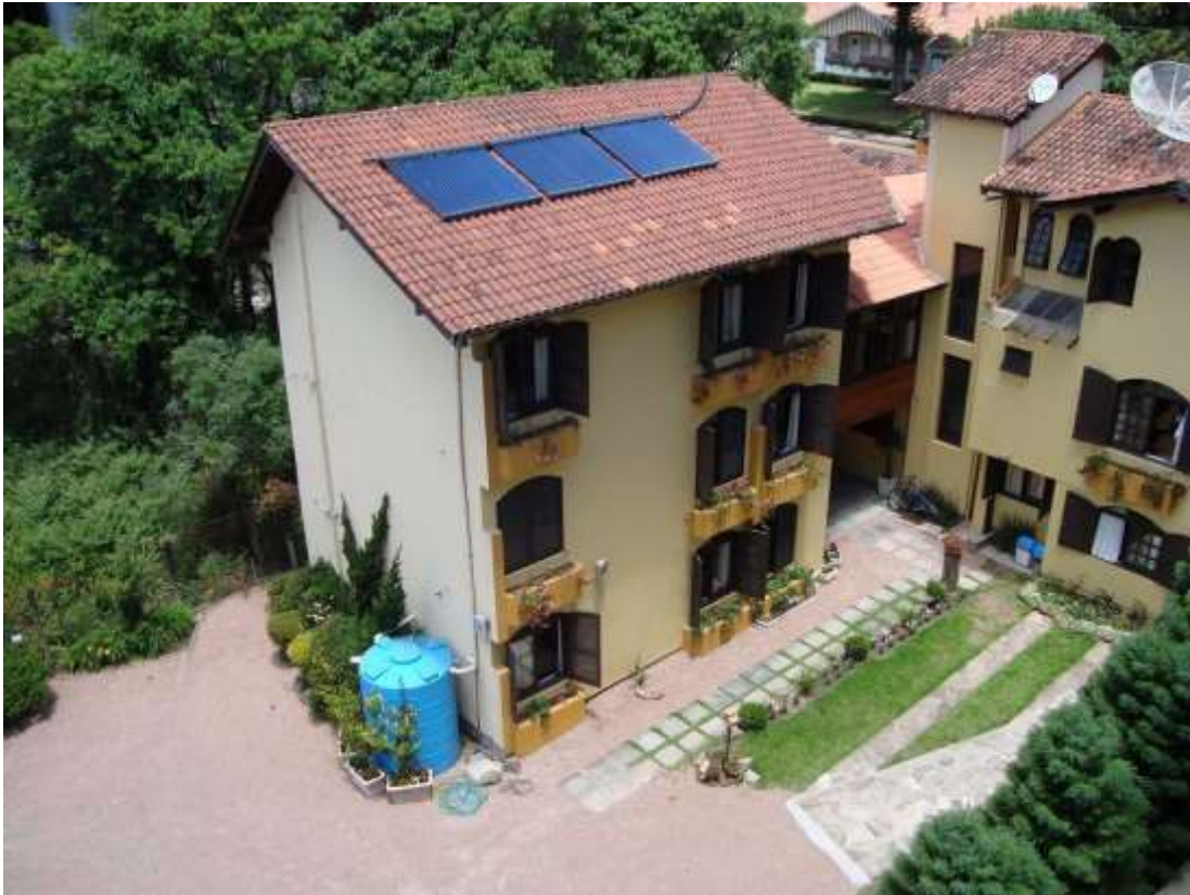
Aquecimento solar e reservatório para água de chuva no hotel pousada
